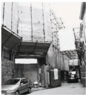
Il cantiere di via Goito. Ieri incontro in Comune
